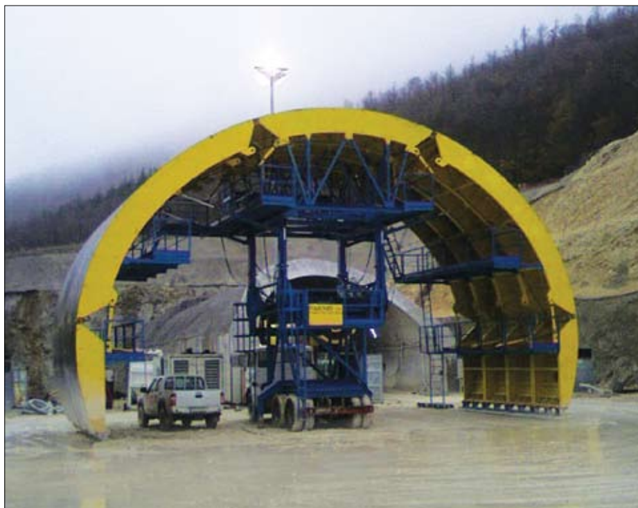
Шоссе А14, тоннель Саппанико, Италия
